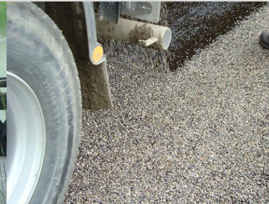
Abstreuen der Oberfläche mit Splitt
